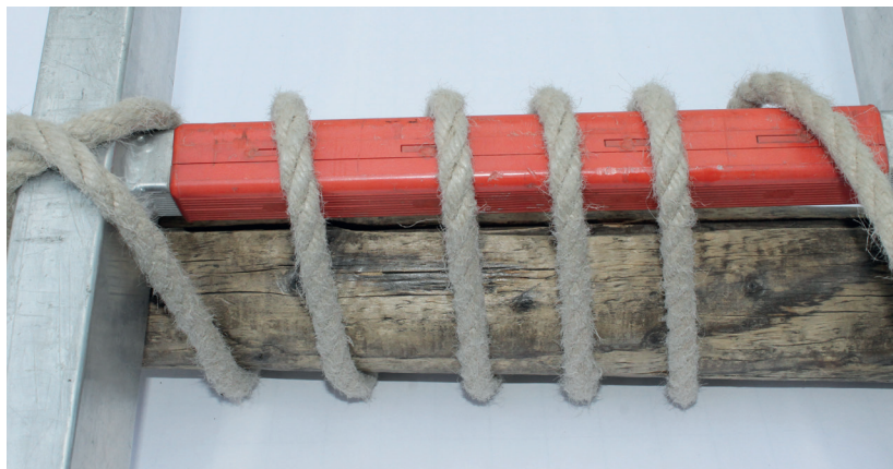
Abb. 22: Kopfpunktsicherung Schritt 3
