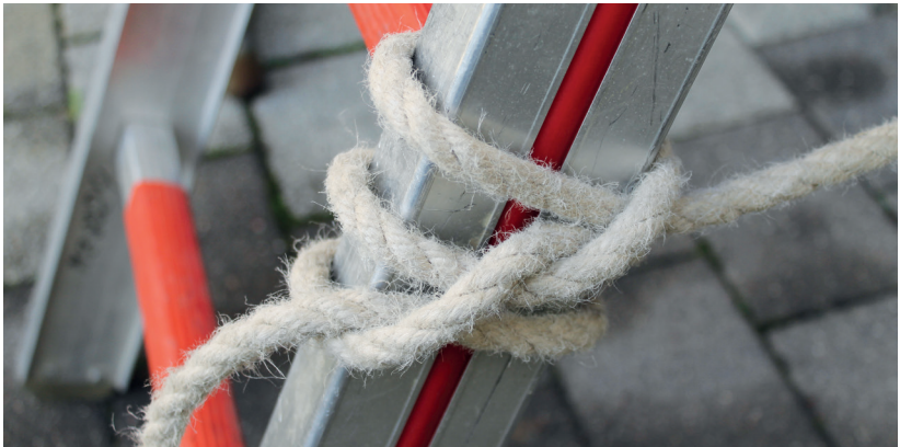
Abb. 28: Fußpunktsicherung Schritt 3
