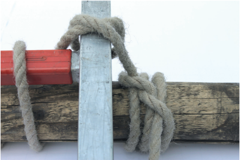
Abb. 24: Kopfpunktsicherung Schritt 5
