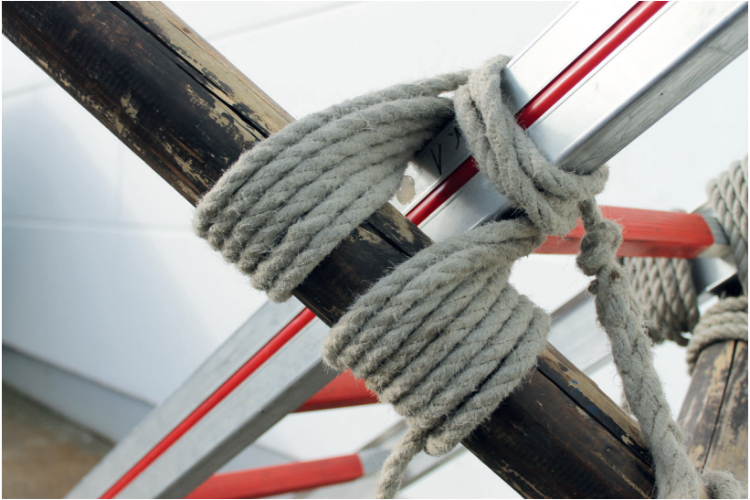
Abb. 32: Verbindung mittels Bockschnürebund
