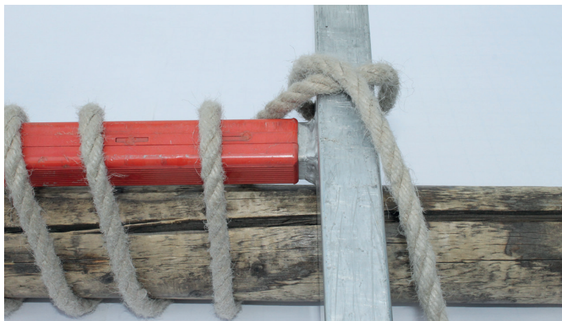
Abb. 23: Kopfpunktsicherung Schritt 4
