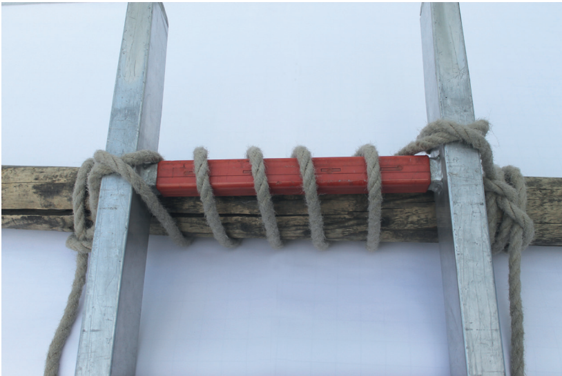
Abb. 19: Kopfpunktsicherung
