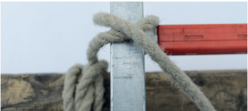
Abb. 21: Kopfpunktsicherung Schritt 2
