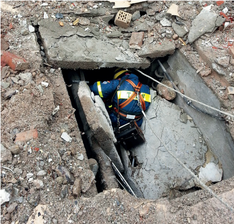
Abb. 52: Eindringen in einen Kriechgang
